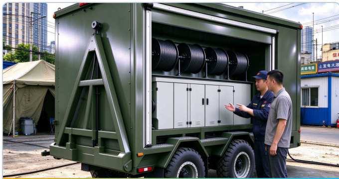
场景 05 临时电力租赁
